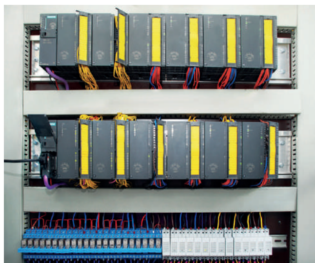
Elektronski uređaj putnog prelaza GFSU LC09
